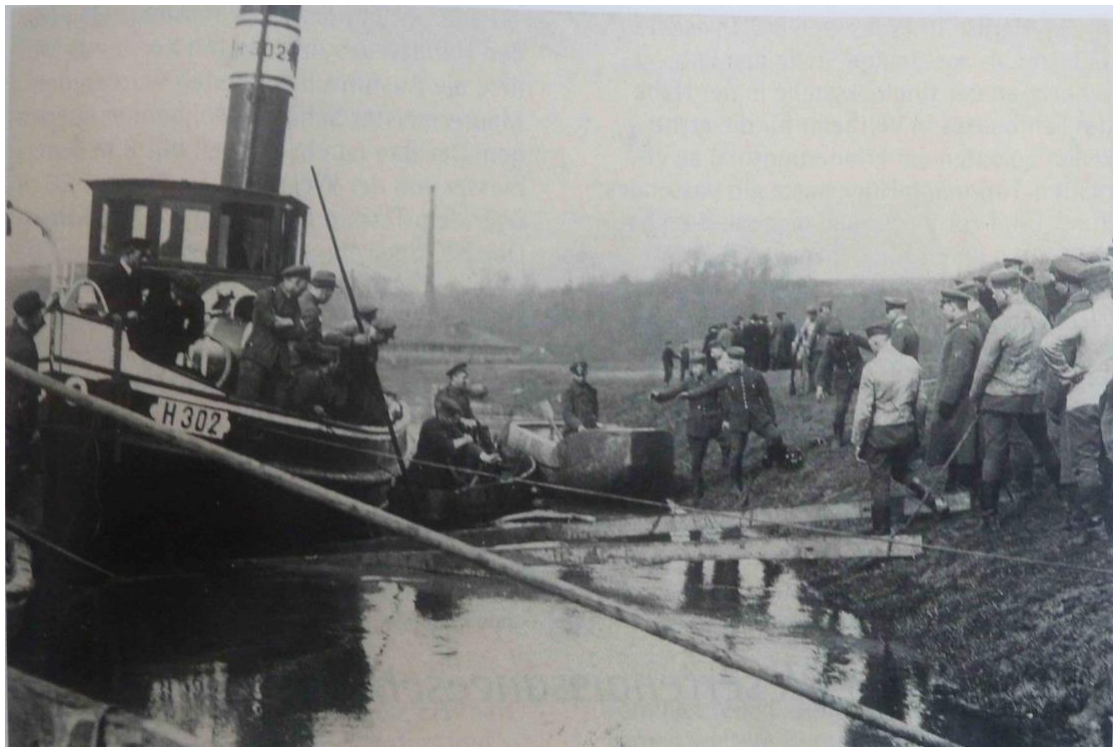
Abb. 3: Einer der Pontons bei den Bergungsarbeiten. Fotografie in der Sammlung Heinz Korff des Arbeitskreises Heimatgeschichte in Varenholz, hier als Kopie aus Siekmann 2000.
