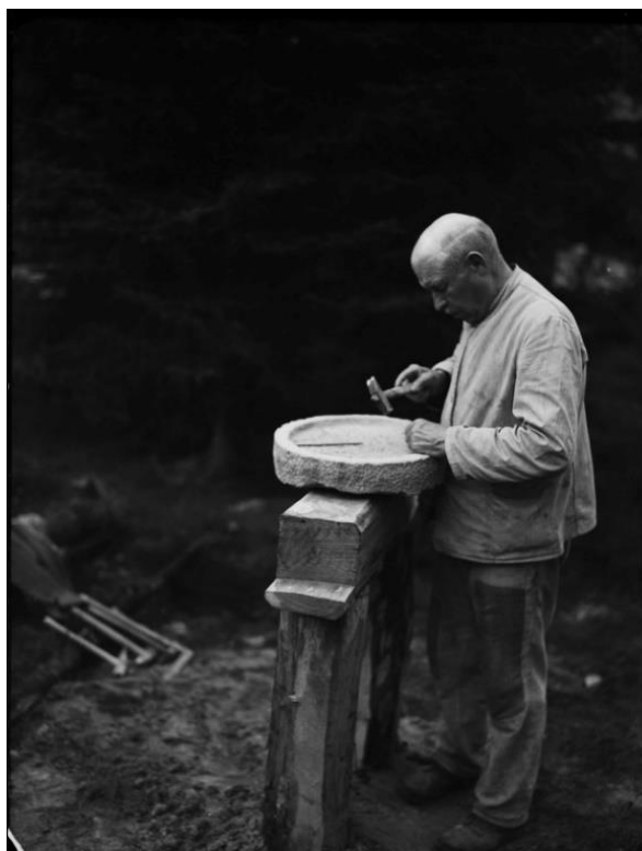
Abb. 3: Bossieren der Handdrehmühle. (ARCHIV FREILICHTMUSEUM OERLINGHAUSEN)
