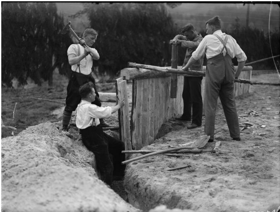
Abb. 2: Setzen der Bohlenwand, 1936. (ARCHIV FREILICHTMUSEUM OERLINGHAUSEN)
