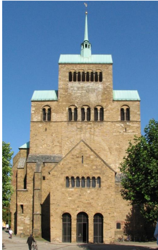
Abb. 2. Der nach Kriegszerstörungen wieder aufgebaute Westriegel des Mindener Doms. Er entstand Mitte des 12. Jahrhunderts zur Zeit der Pilgerreise des Nikulás. (Foto: Aeggy für Wikimedia, 2010, Lizenz BY-SA 3.0)
