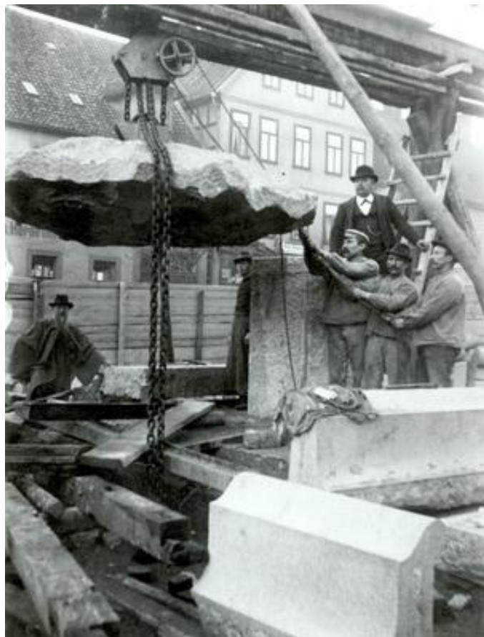
Errichtung des Donopbrunnens, 1902. Stadt A Detmold, BA 76.
