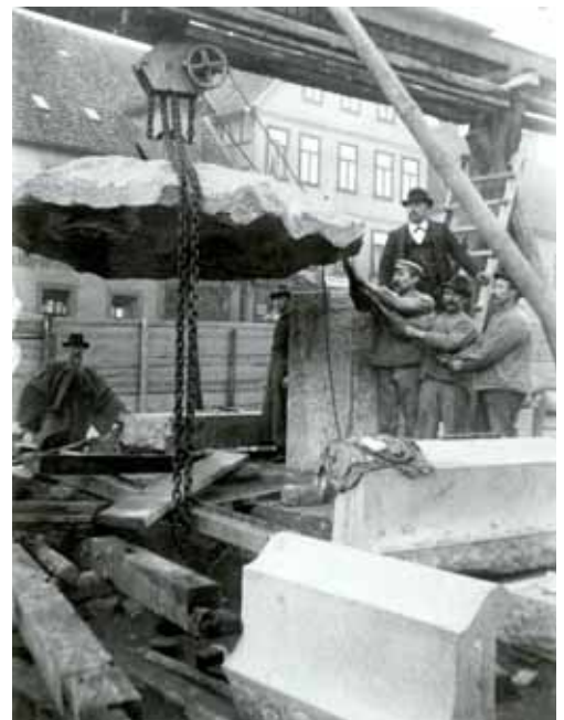
Donopbrunnen im Bau, (Foto: Stadtarchiv Detmold)
